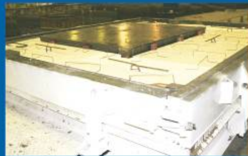
Подготовка производства ж/б панели.
